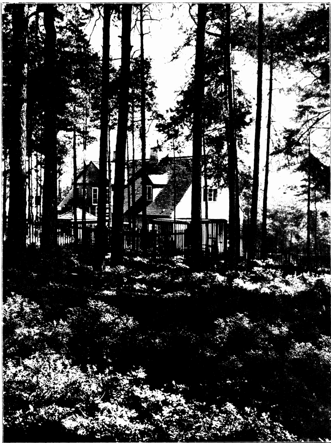
Hellerau: Aus dem Landhäuserviertel (Architekt Heinrich Tessenow)
